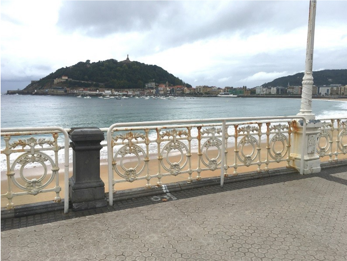
En el tramo de esta fase, algunos tramos de barandilla se protegieron por seguridad
